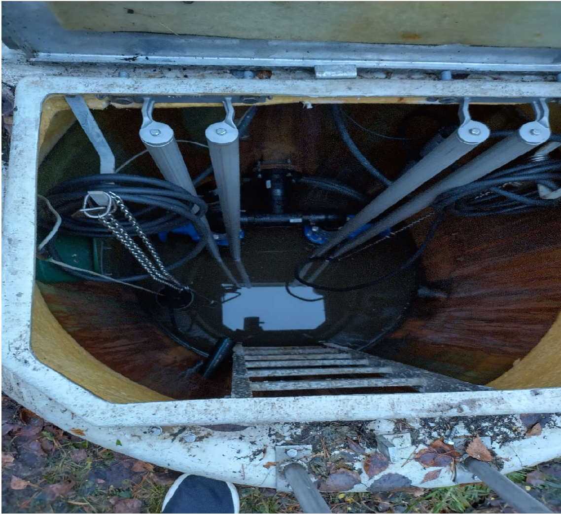
Siirlahden jätevedenpumppaamo saneeraus.
